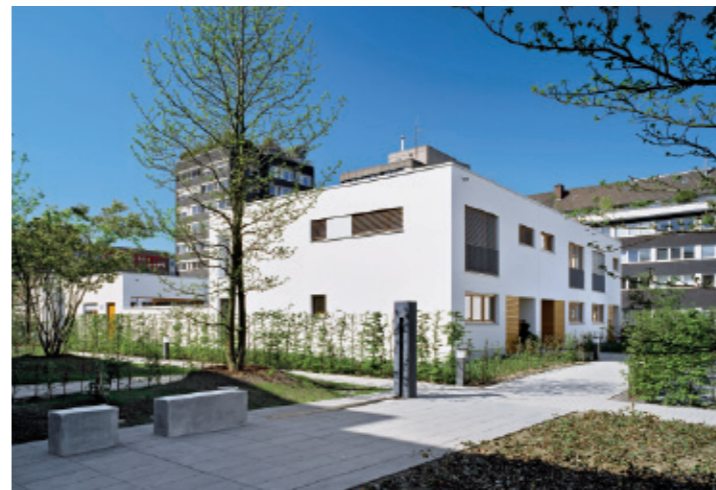
links: Die drei Atriumhäuser bieten im zurückversetzten Obergeschoss neben einem Bad jeweils einen großen Raum mit Loggia an. oben: Die kubischen Baukörper der Atriumhäuser wirken mit ihren weißen Putzfassaden und Holzfenstern schlicht und elegant.
